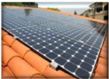
Castell'Alfero - 5,40 kW Impianto integrato Moduli SUNPOWER
