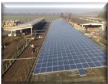
Valle Lomellina 396,60 kW Impianto parzialmente integrato
