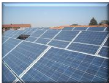
Scuole medie di Costigliole d'Asti - 19,80 kW Impianto non integrato Moduli CONERGY
